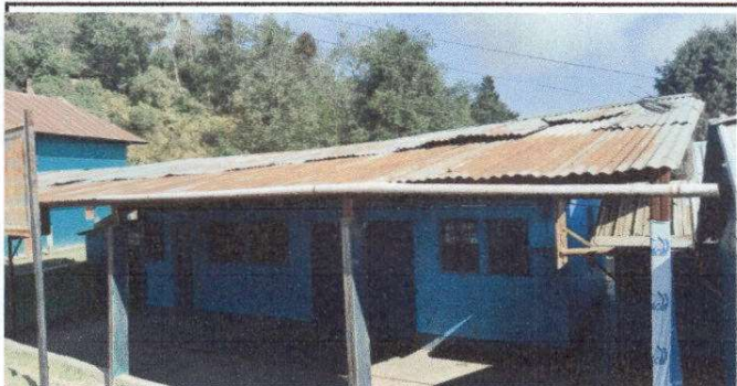
Foto1: Sustitución de lámina troquelada aluzinc calibre 26
