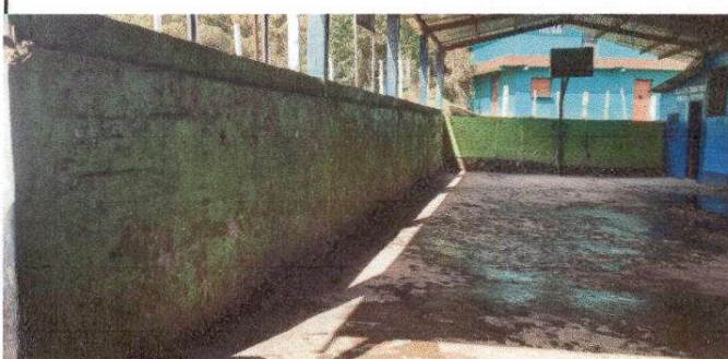
Foto 5: Repello de muro
