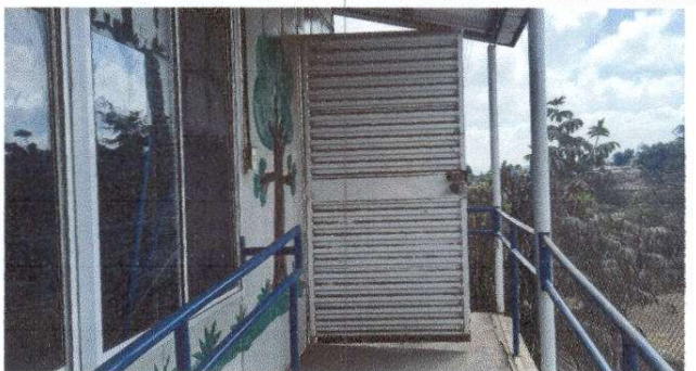
Foto 6: Sustitución de puerta
