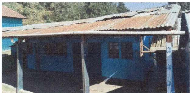
Foto 3: Sustitución de canal PVC
